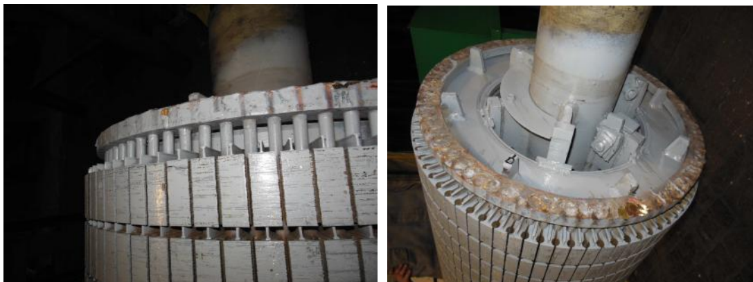
Rys. 10. Wirnika silnika dwuklatkowego 400 kW z uszkodzoną klatką pracy – widok na wirnik przed demontażem klatki rozruchowej (niewidoczne uszkodzenie), po demontażu z widocznym uszkodzeniem połączenia pierścieni zwierający - pręty
