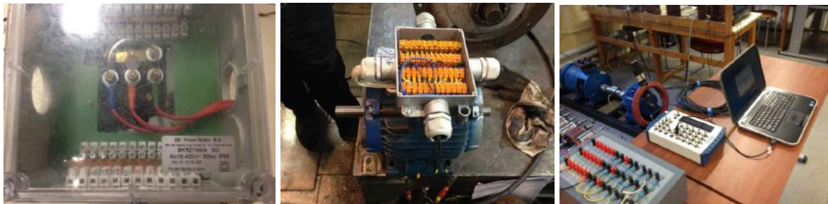
Rys. 4. Widok elementów stanowiska do badania uszkodzeń silników o mocy 4 kW ze zmodyfikowanymi stojanami silnika do symulacji zwarć oraz zestawionym układem pomiarowym
